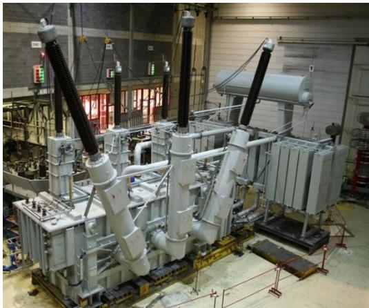
Abb. 9: 750 MVA-Drehstrom-Spartransformator [5]
